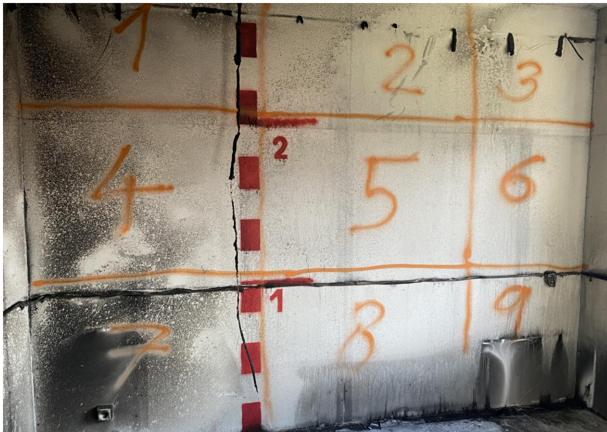
Obrázek č. 10.27 Pohled na měřenou SDK stěnu rozdělenou na sektory
