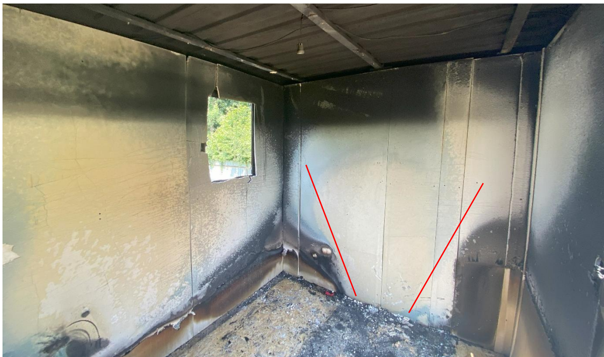
Obrázek 11.6 Pohled na opačnou stranu místnosti (mimo ohnisko), kde došlo k vypálení charakteristického znaku „V“
