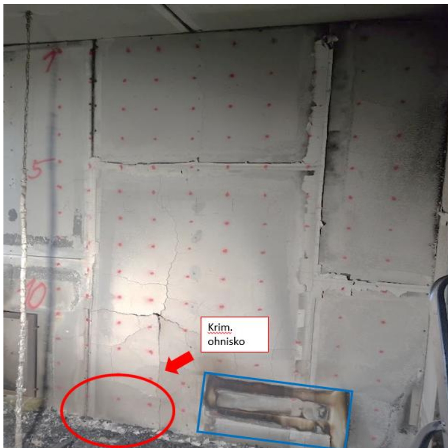
Obrázek č. 10.5 Pohled na měřenou SDK stěnu.
