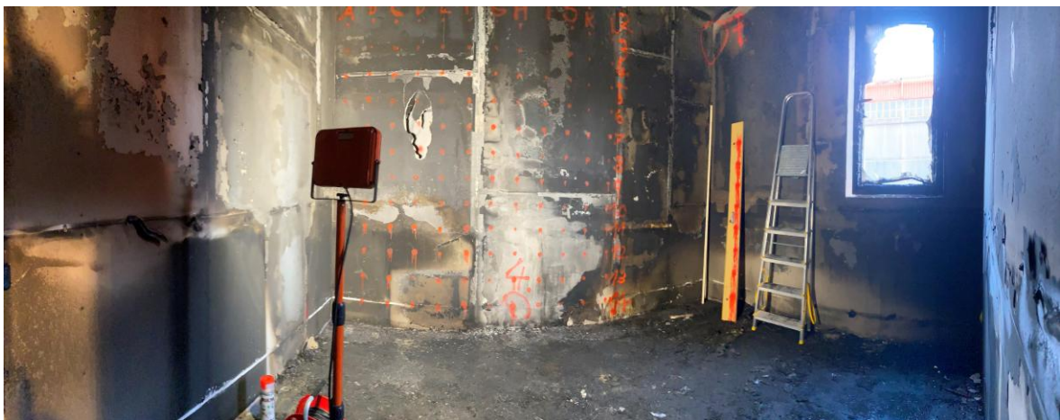
Obrázek č. 10.13 Pohled na měřenou SDK stěnu.
