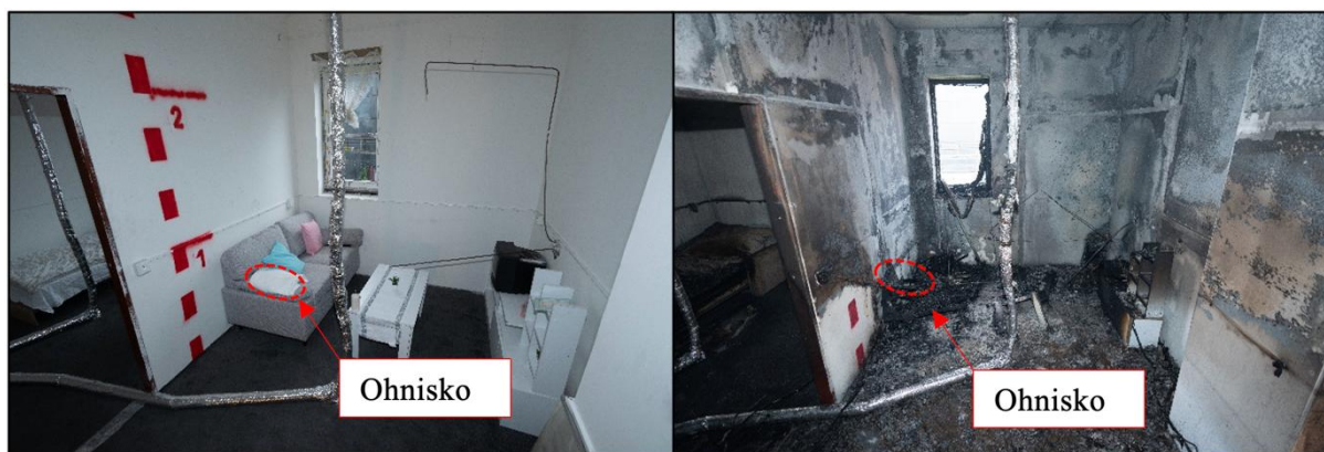
Obrázek č. 10.23 Na levém obrázku je zobrazen prostor obývacího pokoje před požárem a na pravé po požáru s vyznačeným ohniskem
