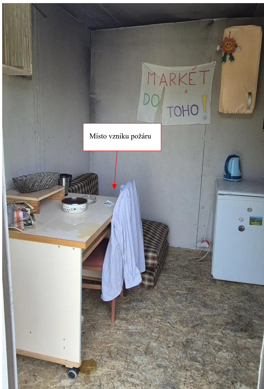
Obrázek 11.10 Pohled do buňky s naznačeným místem vzniku požáru. Z tohoto pohledu za křeslem umístěným v levém horním rohu místnosti.
