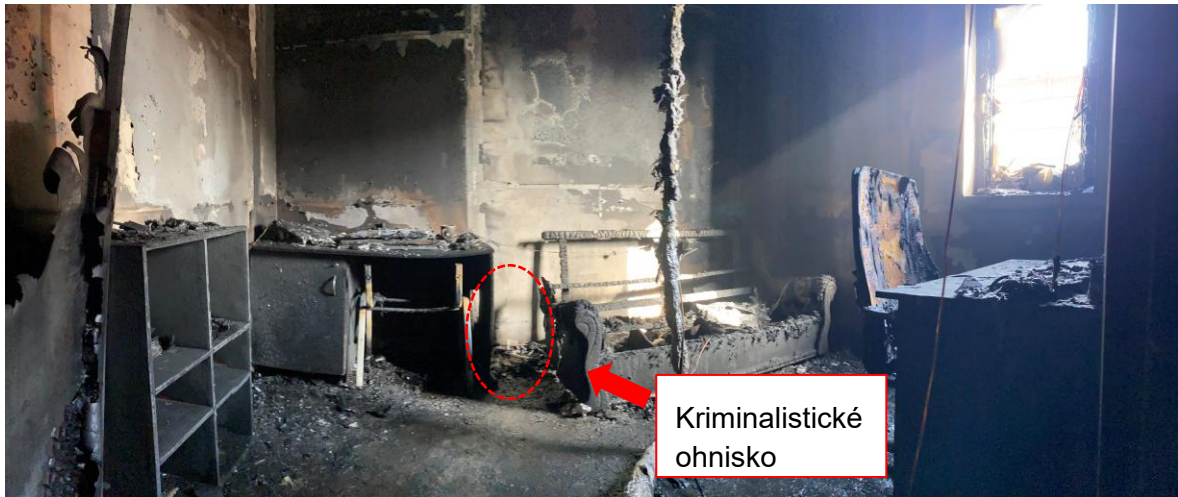
Obrázek č. 10.12 Zobrazení kriminalistického ohniska. Proběhlo proměření SDK stěny přilehlé ke kriminalistickému ohnisku.
