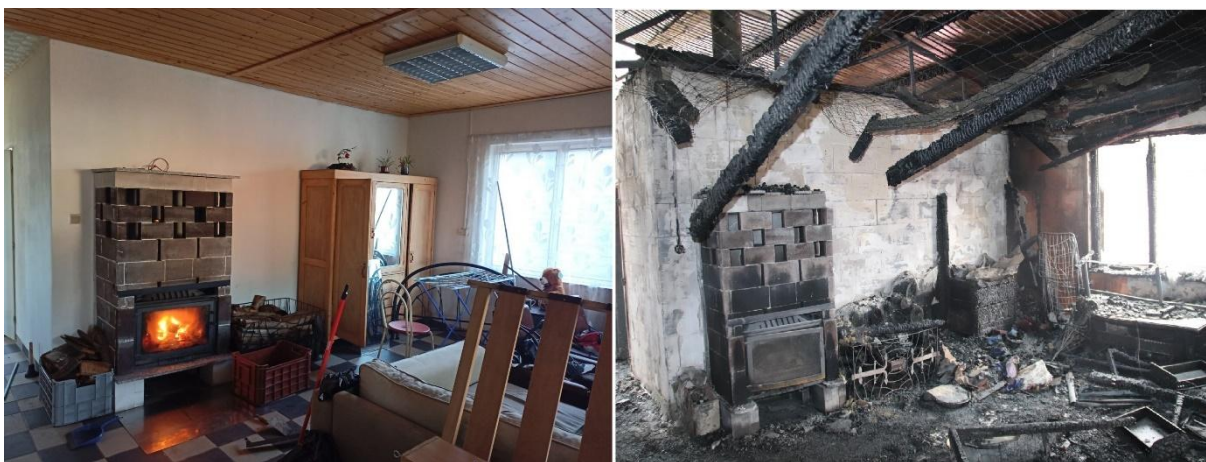
Obrázek 4 Foto stejné místnosti v období před požárem a po požáru (Zdroj: HZS ČR)
