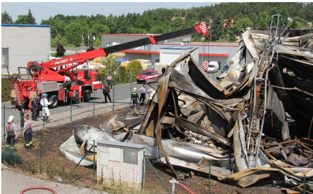
Obrázek 3 Příklad nasazení těžké techniky (jeřábu) za účelem vytvoření přístupu k oblasti místa vzniku požáru, (Zdroj: HZS ČR)
