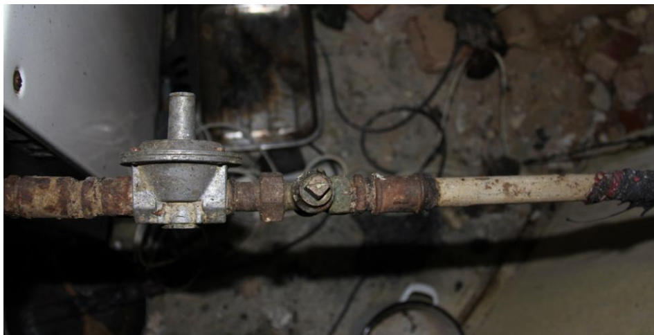
Obrázek 7 Dokumentace přívodu plynu a polohy hlavního uzávěru ke kombinovanému sporáku (Zdroj: HZS ČR)
