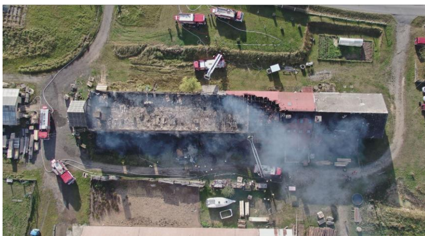
Obrázek 22 Záběr z dronu umožňující dokumentaci místa požáru (Zdroj: HZS ČR)
